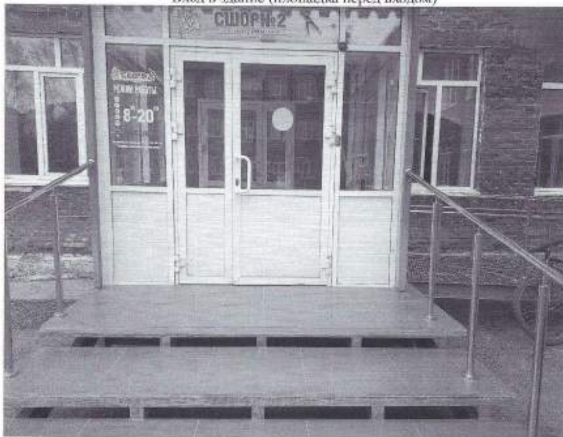
Вход в здание (площадка перед входом)
