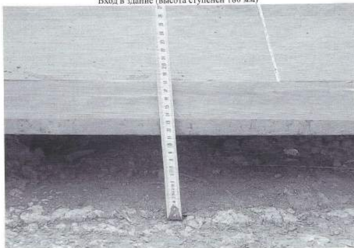
Вход в здание (высота ступеней 180 мм)
